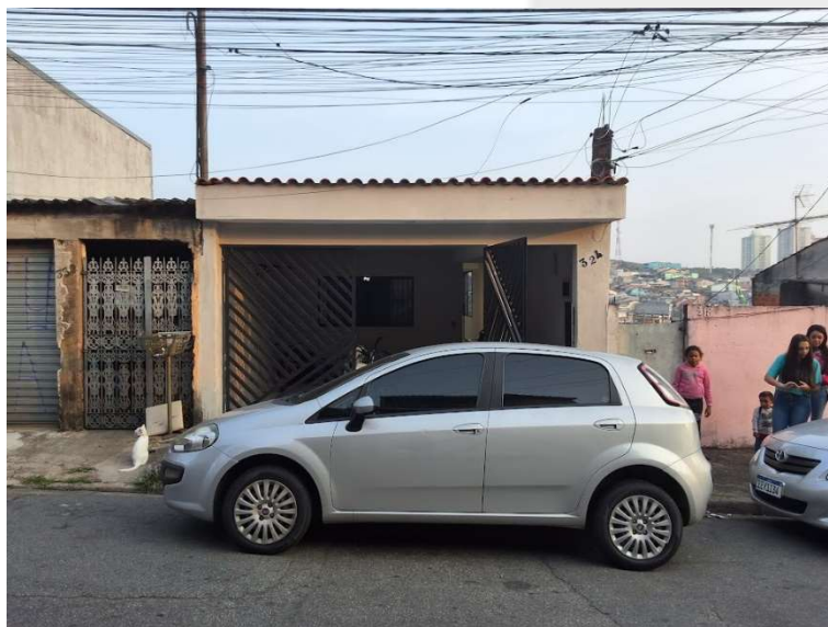
Figura 2 -Fachada do imóvel - Fonte: Autor.
