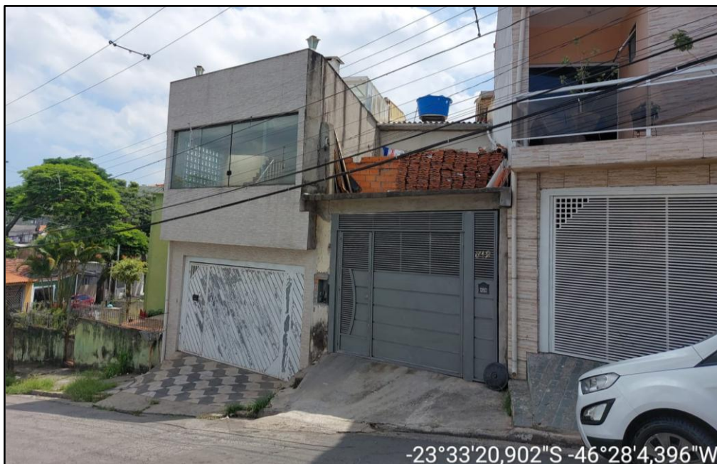
Foto 1 – Vista frontal do imóvel e imóveis vizinhos
