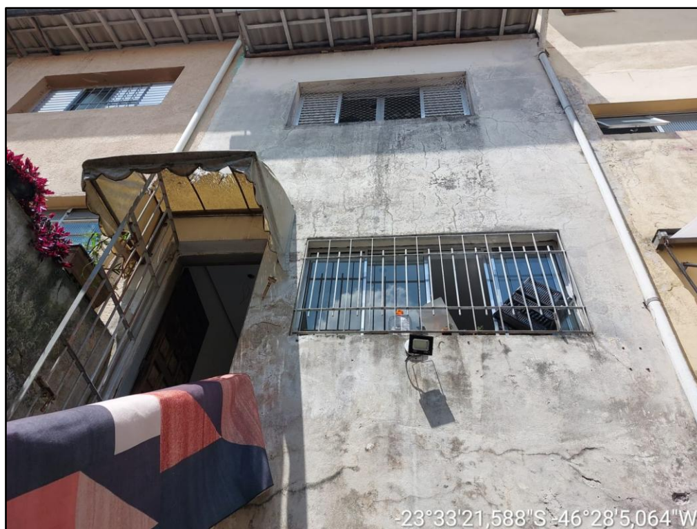
Foto 11 – Fachada dos fundos
