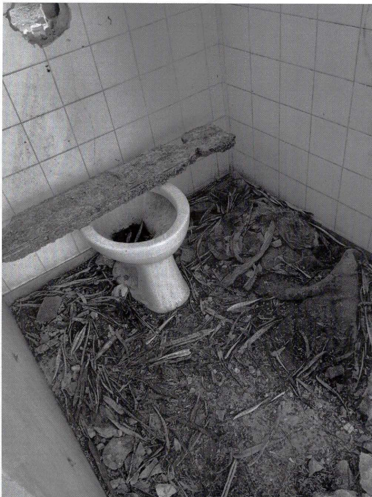
Descrição: Possíveis criadouros de mosquito.
