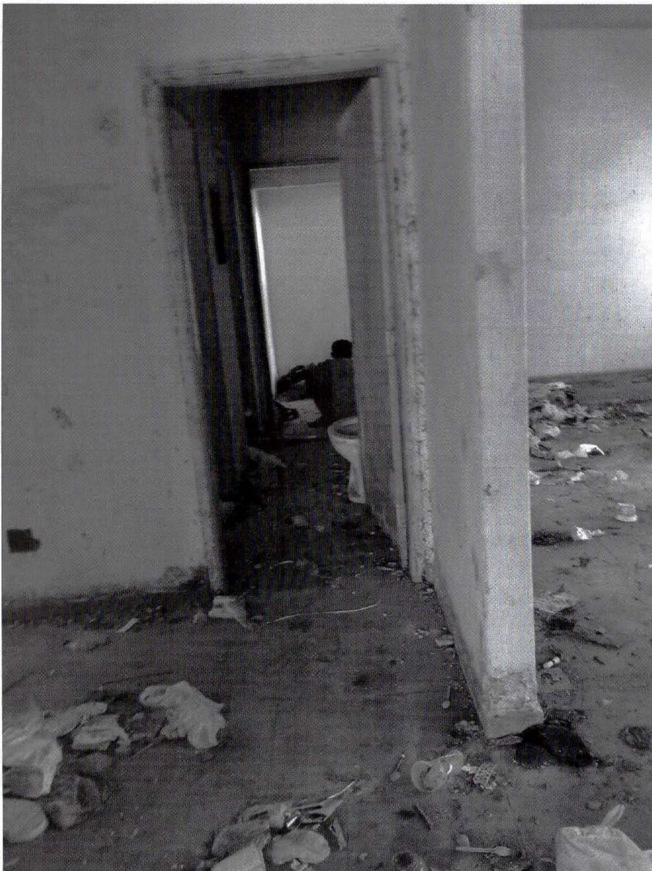
Foto 05 – Descrição: Ocupação irregular.
